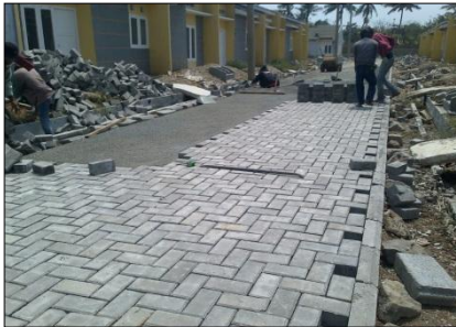
Project pengerjaan Paving Perum Griya Asri Sukamanah Rajeg, Tangerang
