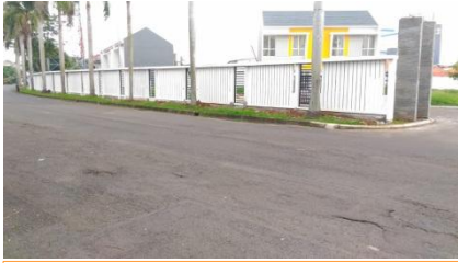
Project Pengerjaan Trotoar, Modern Land, Tangerang
