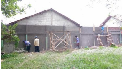
Project Pengerjaan Pagar Perum Modern Land 1, Tangerang
