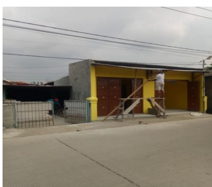
Project Pengerjaan Kios, Tangerang
