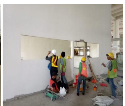
Project Pengerjaan Bangunan LRT Kelapa Gading, Jakarta
