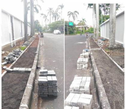
Project pengerjaan Trotoar Jl. Boulevard Modern Land, Tangerang
