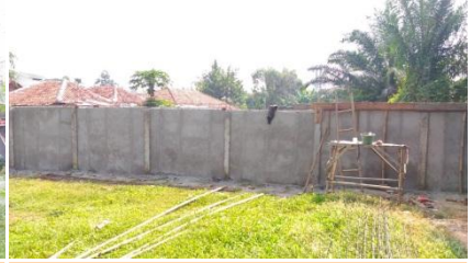
Project Pengerjaan Pagar Perum Modern Land 2, Tangerang
