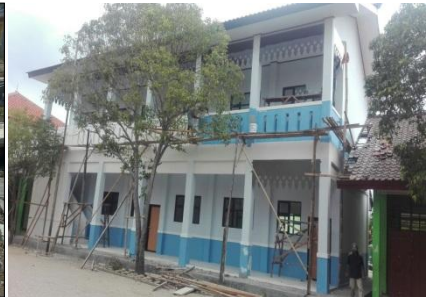
Project Pengerjaan Gedung SMPN 1 Babelan, Bekasi
