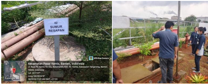
Project Perpanjangan SIPA RS. Primaya, Pasar Kemis Tangerang
