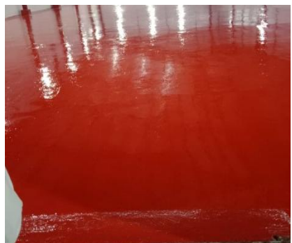
Project Pengerjaan Cat Epoxy LRT Kelapa Gading, Jakarta
